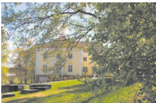
Onni Tourun suunnittelema Vanhalinnan uusklassistinen päärakennus valmistui vuonna 1930.
